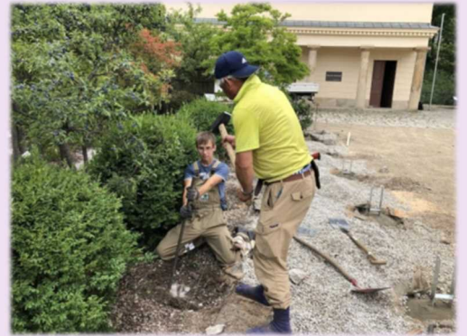
支柱の基礎を作るための穴掘り作業
