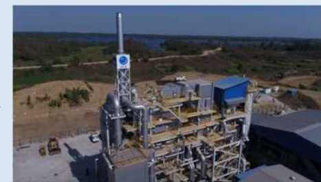
廃棄物発電施設
