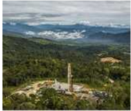
質の高いインフラの例 インドネシア地熱発電案件 (出典:ADB)
