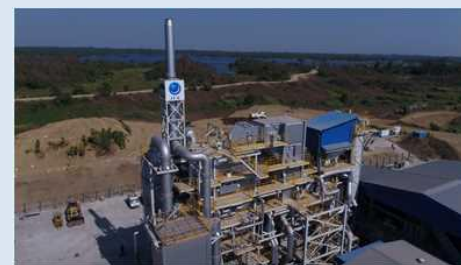
廃棄物発電施設
