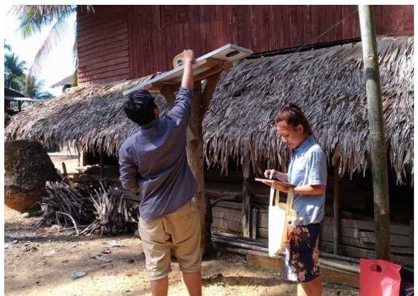
写真19: 完成検査 ソーラーパネル角度チェック
