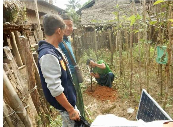
写真17: ソーラーパネル支持柱掘削
