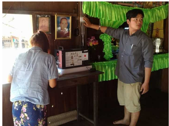
写真21: 完成検査 屋内配線チェック
