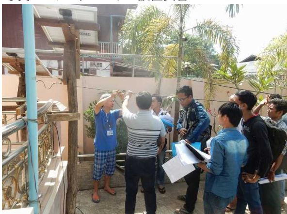
写真11: 施工業者との屋外配線施工方法確認
