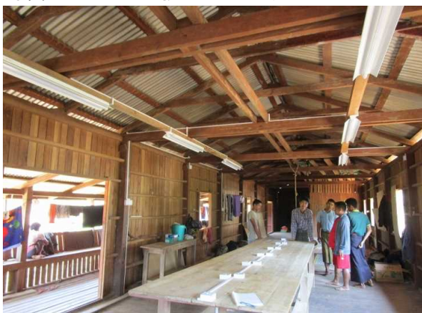
写真37: 教室照明、コンセント施工完了
