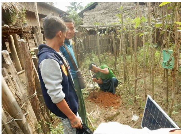
写真17: ソーラーパネル支持柱掘削
