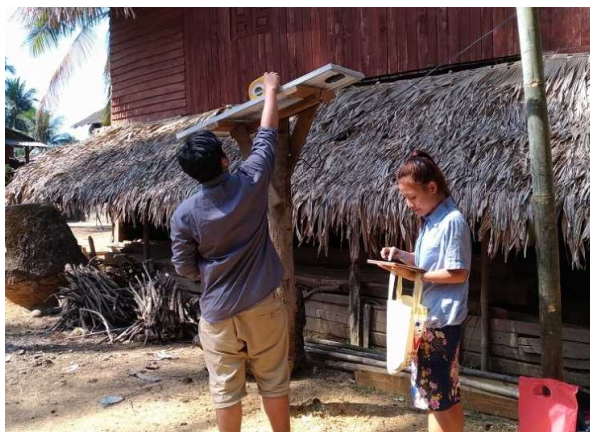
写真20: 完成検査 ソーラーパネル角度チェック
