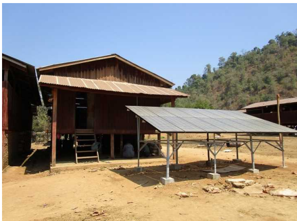
写真29： 生徒寮、食堂向けソーラーパネル
