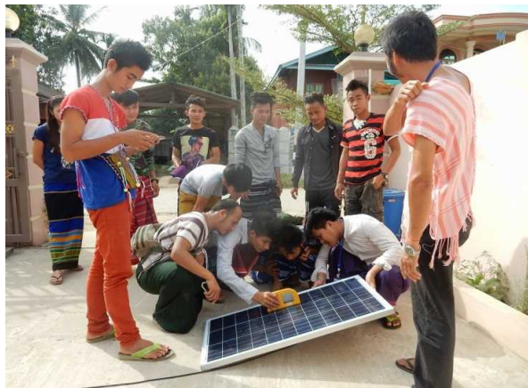
写真9: ソーラーパネル設置実習
