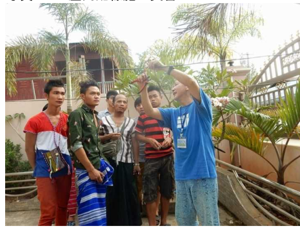
写真12: 屋外配線施工実習
