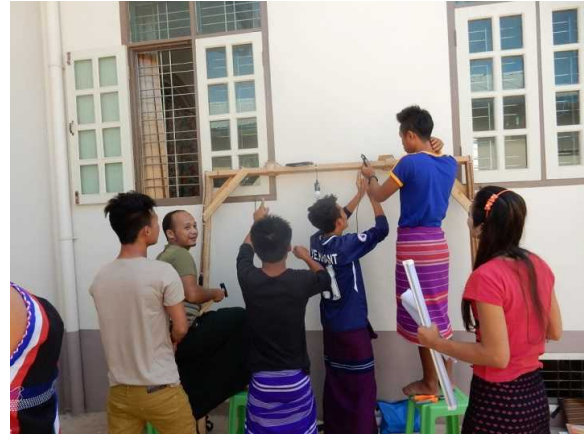
写真10: 屋内配線施工実習
