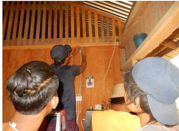
写真19: 屋内配線作業
