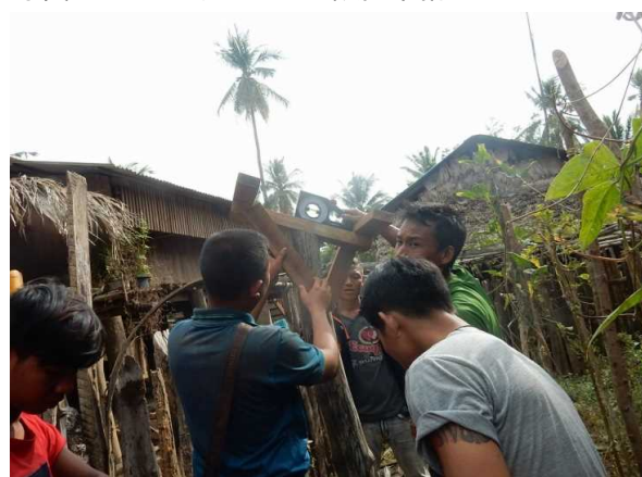
写真18: ソーラーパネル設置角度調整
