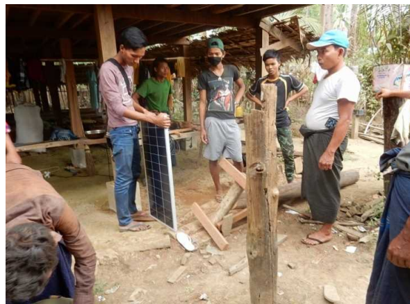
写真16: ソーラーパネル設置準備
