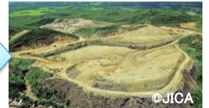
覆土によるごみの飛散・流出を防止
