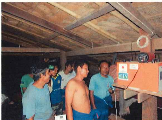
メンテナンス委員へのソーラーシステム説明会 2 (Kayin 州, Lae Ka Tae 村 (SPR13))
