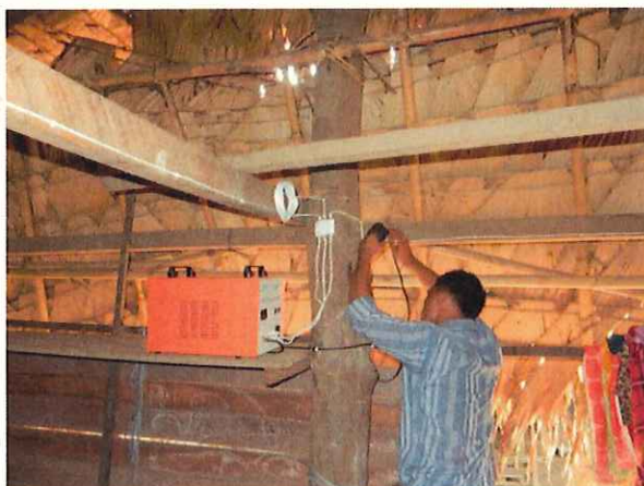
ケーブルの配線模様 (Kayin 州, Lae Ta Tae 村 (SPR13))
