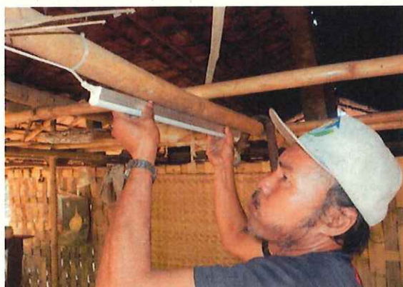
メンテナンス委員がLEDチューブ取替え (Kayin 州, Ta Oh Khee 村 (SPR14))
