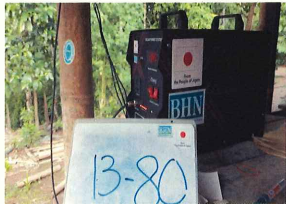
検査完了後最終確認 2 (Kayin 州, Lae Ka Tae 村 (SPR13))
