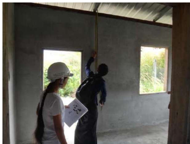
事業地訪問における施工監理
