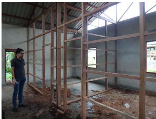
事業地訪問における施工監理
