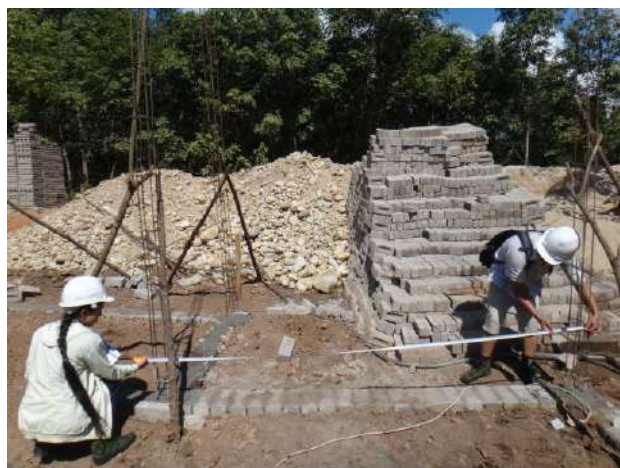
事業地訪問における施工監理
