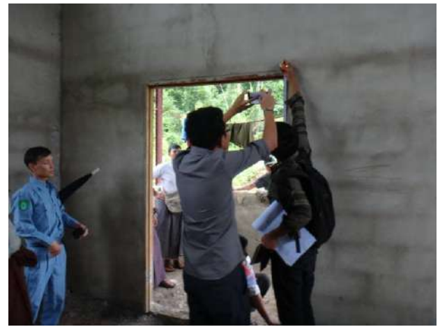
事業地訪問における施工監理
