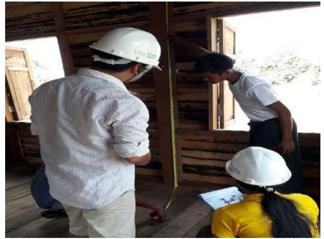
事業地訪問における施工監理
