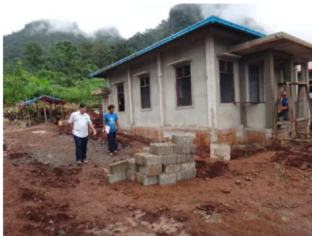
事業地訪問における施工監理
