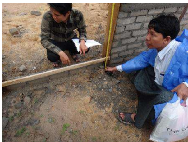
事業地訪問における施工監理
