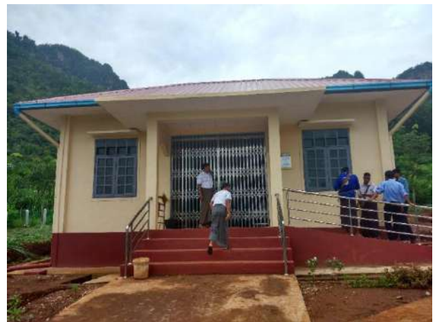
完成したヘルスケアセンター
