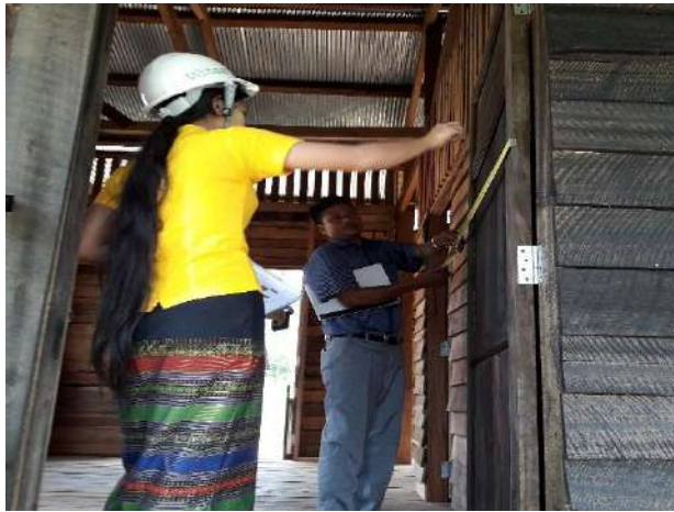
事業地訪問における施工監理
