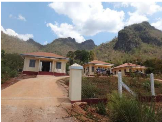
完成したヘルスケアセンター
