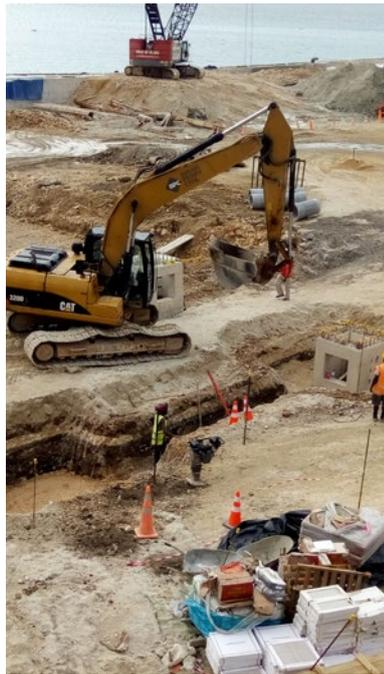
バヌアツのポートビラ港パタシ国際多目的埠頭整備計画プロジェクトサイト。排水パイプの設置のための掘削工事の様様。(写真：武田晶／(株)エコー)
