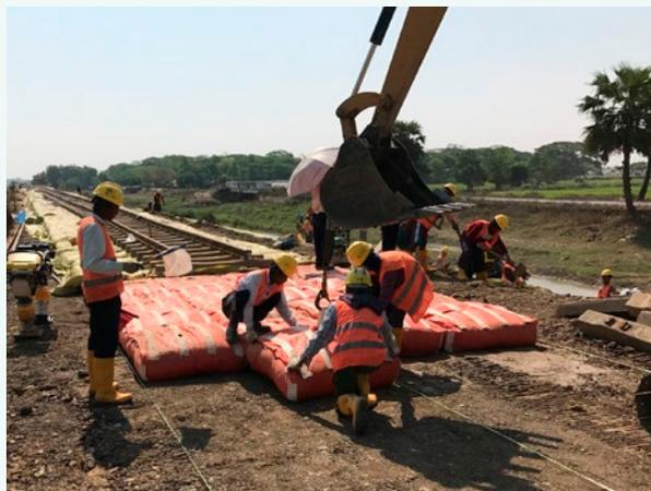
ミャンマーの鉄道整備工事でD・BOXを敷設している様子。
