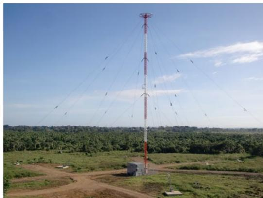
中波ラジオのアンテナ。(写真：JICA)
