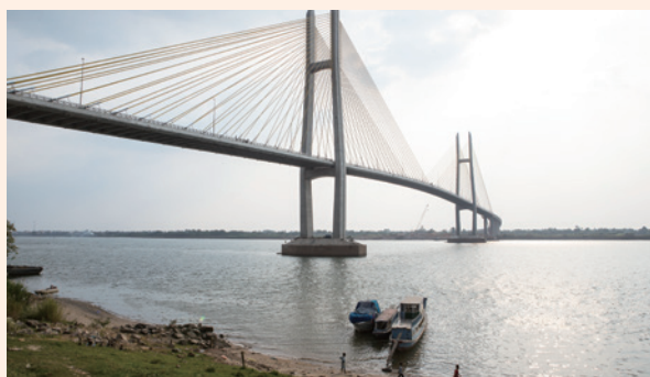
カンボジア：南部経済回廊に架かる「つばさ橋」 (写真提供：久野真一／JICA)
