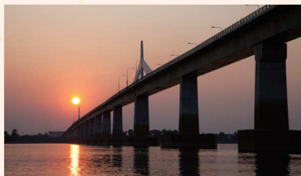
ラオス：東西経済回廊に架かる「第2メコン橋」 (写真提供：久野真一／JICA)
