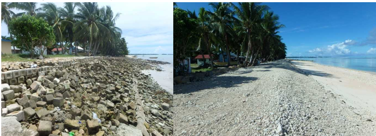
図 29 ツバル国フォンガファレ島における礫養浜。養浜前（左）、養浜後（右）（写真提供：日本工営）
