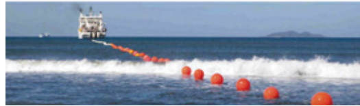
南大西洋における光海底ケーブル敷設プロジェクト (画像提供: NEC)
