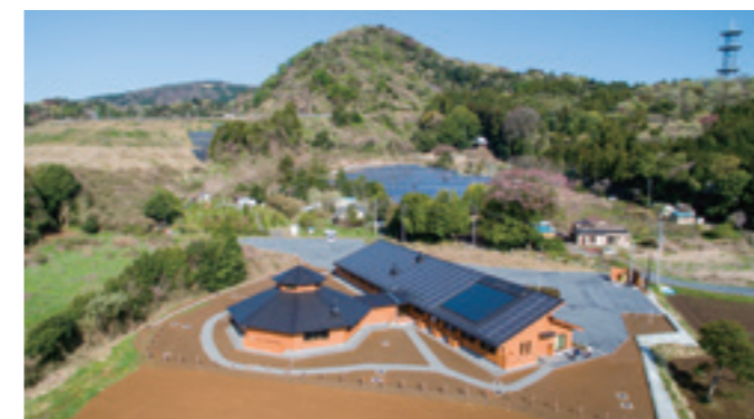
生長の家 茨城県教化部新会館(茨城県笠間市)
