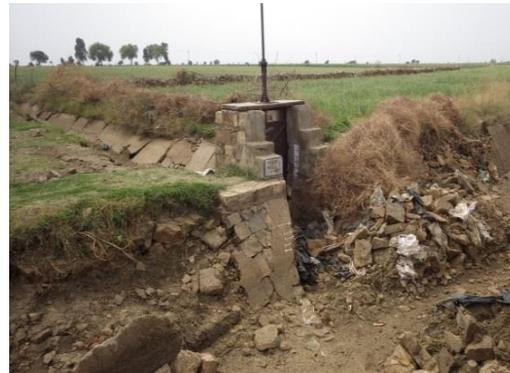
【老朽化によって破損した既存の灌漑施設: 事業を通じて改修され、乾期でも圃場に水が届けられるようになる。】
