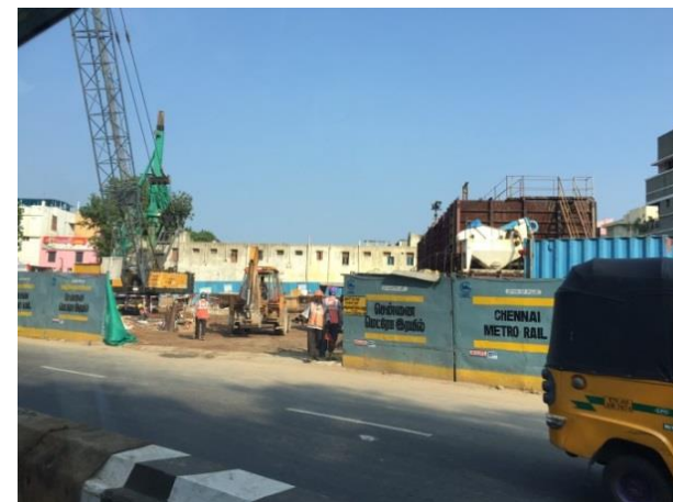
【Korukkupet駅(地下)の建設現場:円借款対象外の区間のため、先方負担で既に建設が始まっている。】
