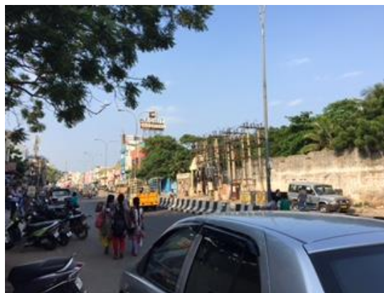
【Gowri Ashram駅(高架)建設予定地:道路直上に駅が建設される予定。】
