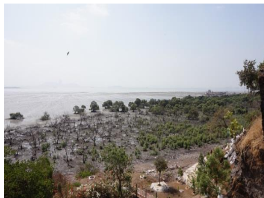
【ムンバイ側架橋位置。】
