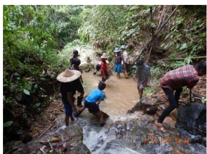
給水設備設置
