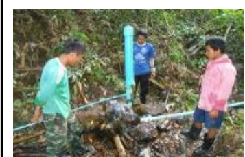
給水設備の設置
