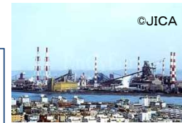
日本のODA資金が建設に使用された浦項総合製鉄所
