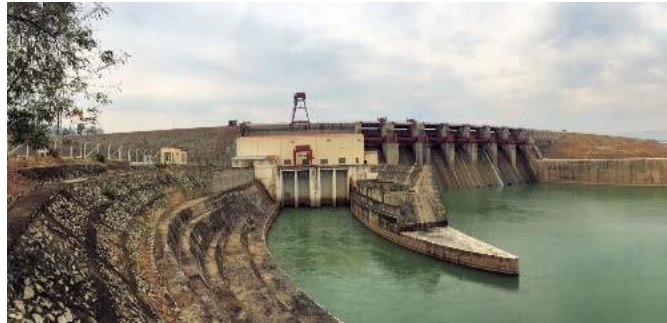
発電所放水口全景
