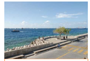
モルディブの護岸は、巨大津波から住民の命を守った。
