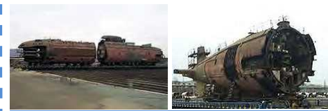
※ヴィクターIII級原潜の解体作業中の様子。2003年から2009年にかけて、ロシア極東地域で保留されていたロシア退役原潜のうち6隻が我が国の支援により解体され、テロリスト等による核物質取得や艦体腐食による放射能汚染の防止等にも貢献。
