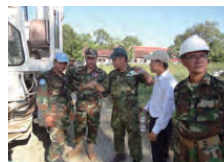
道路の勾配の付け方について説明している様子
