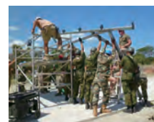
各国軍との連携による鉄骨の組み立て作業の様子
