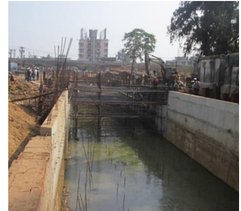
【建設中の幹線排水路】
