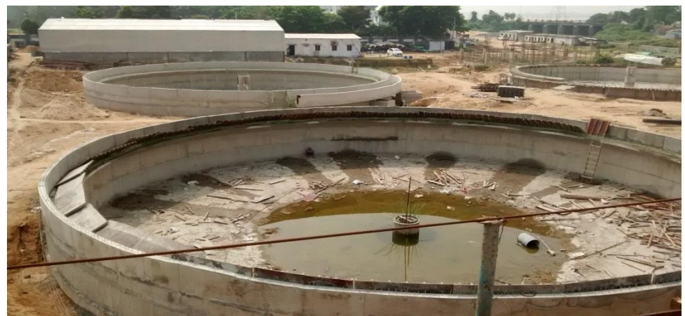
【建設中のカタク市の下水処理場の初期沈殿槽及び最終沈殿槽】
