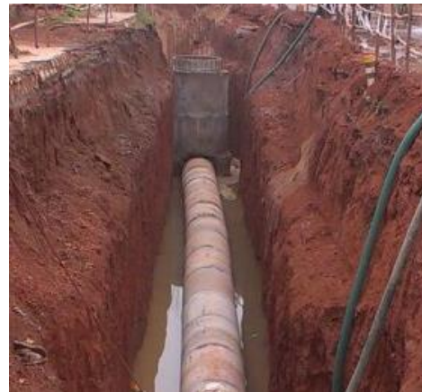
【建設中の下水管渠】
