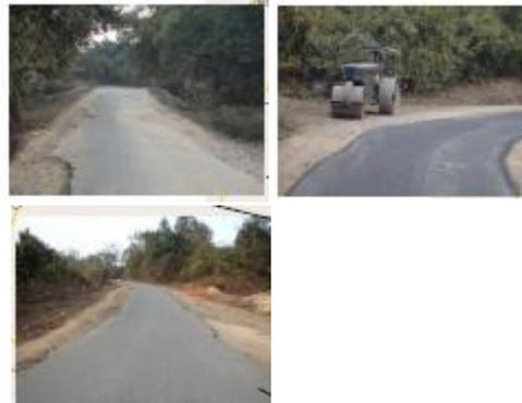
【ミゾラム州国道54号線。道路の拡幅、舗装、斜面災害対策を実施する。】
