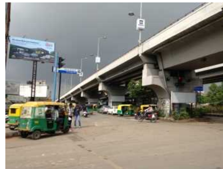
【Gujarat University駅建設予定地。 既存の高架の上にメトロ路線を建設予定。】
