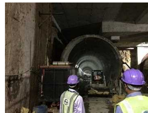
【Pachaiyappa's College駅付近の シールドトンネルの建設現場】
