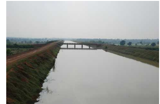
【幹線水路の様子(フェーズ1)】
