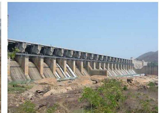
【レンガリダム(1985年完成)の様子】
