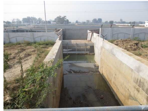
【完成済みの取水施設(新設)】
