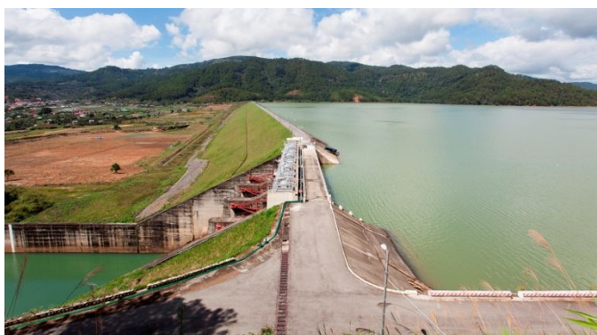
ダニム水力発電所(ダム本体)
