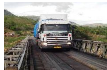
一車線のための現行の橋
