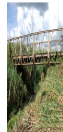
現行の仮設橋
