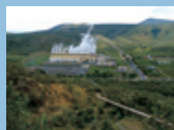
オルカリア地熱発電プラント
