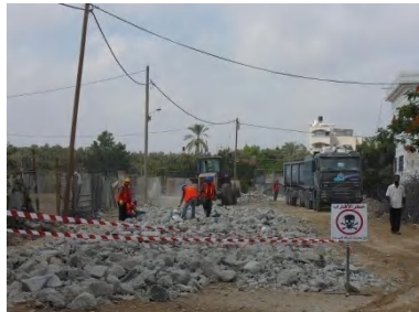
不発弾及び瓦礫除去作業
