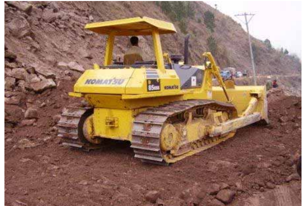
道路の補修工事を行うブルドーザ
