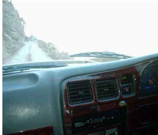
地すべりの発生で塞がれた道路
