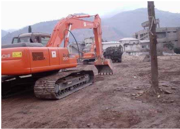
瓦礫の撤去作業を行うエクスカベータ
