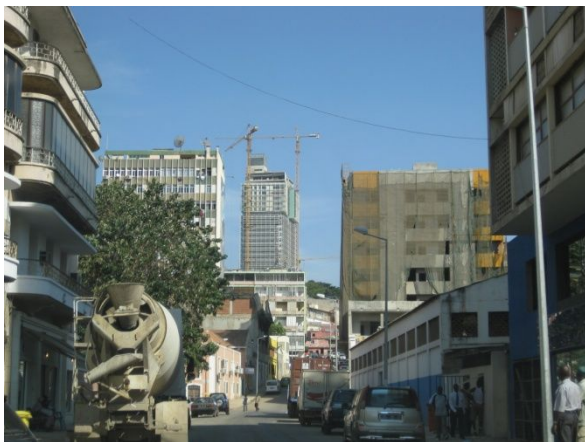
ルアンダ市内(建設ラッシュ)
