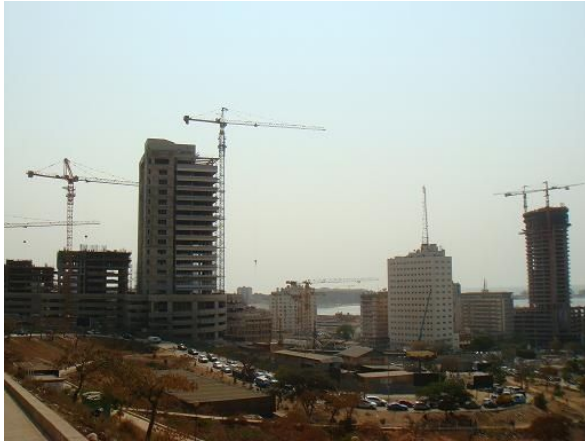
ルアンダ市内(建設ラッシュ)
