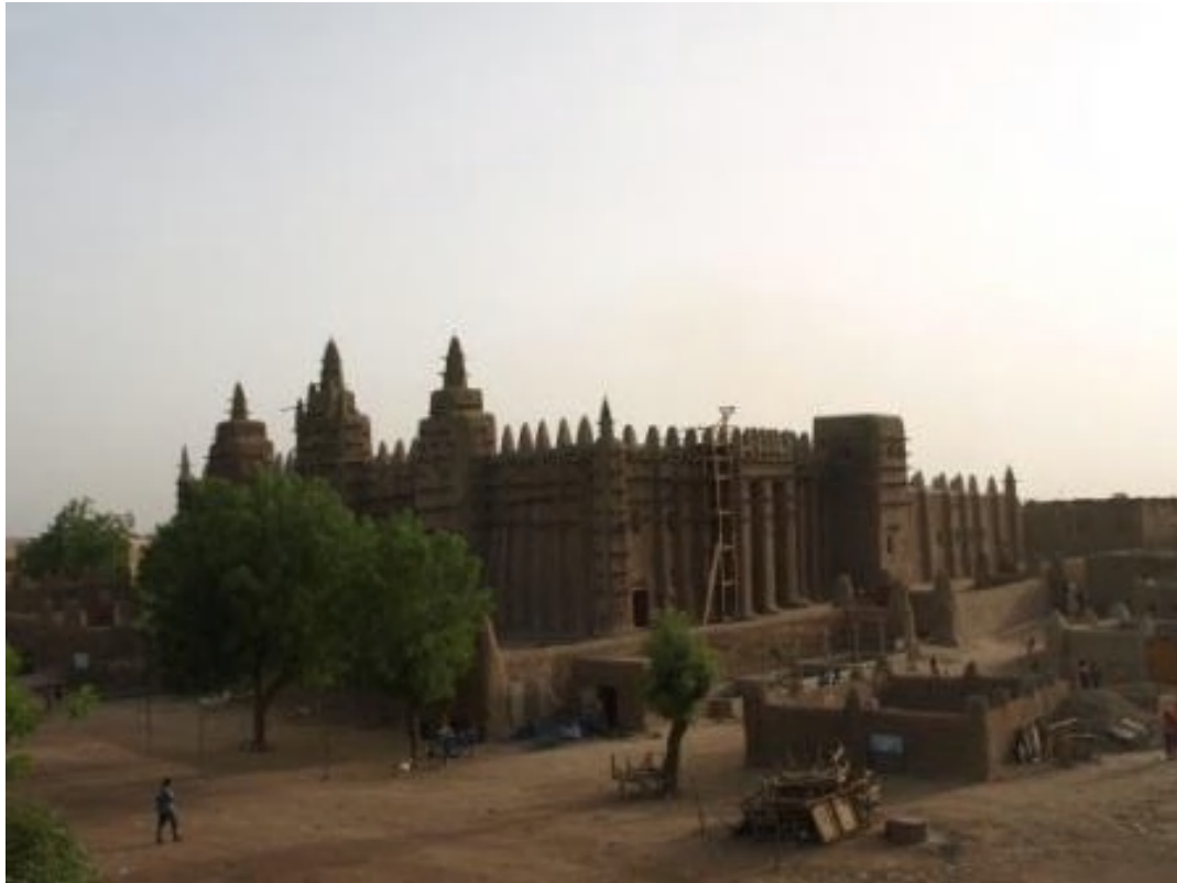
「ジェンネの旧市街」泥の大モスク。梯子をかけ、今年の泥の塗り替え準備を行う。
