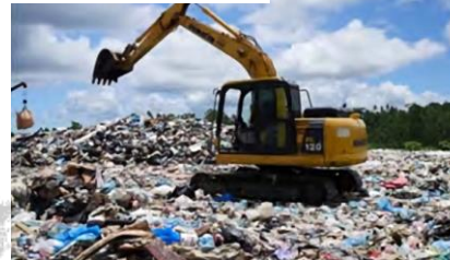
パラオ廃棄物処分場
