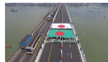
メグナ第2橋（バングラデシュ） （写真提供：大林組・清水建設・ JFEエンジニアリング・IHインフ ラシステム共同企業体）
