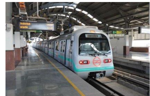
インド「デリー高速輸送システム建設事業」
