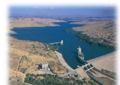
Soutien à la formulation d'un projet de remise à niveau de barrage (Tunisie)
