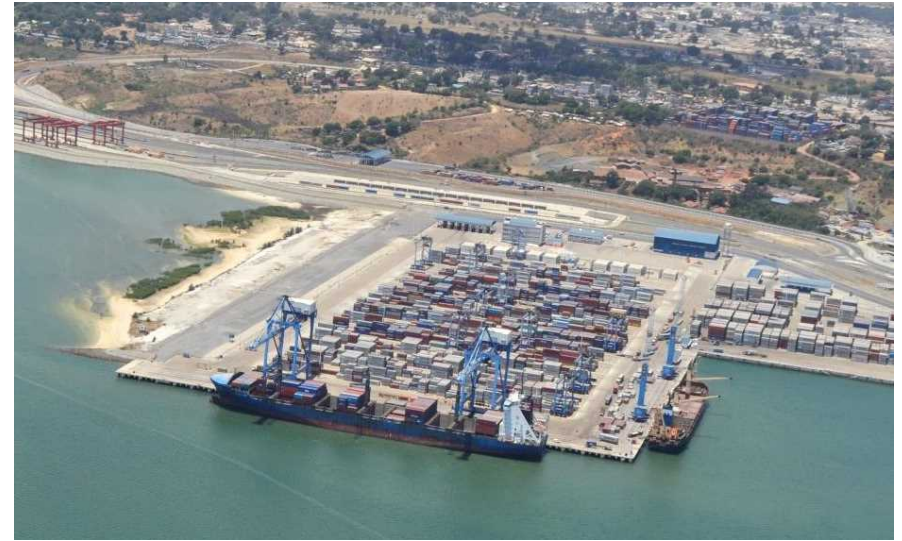
ケニア：円借款により供与されたモンバサ港の新コンテナターミナル (写真提供：東洋建設)
