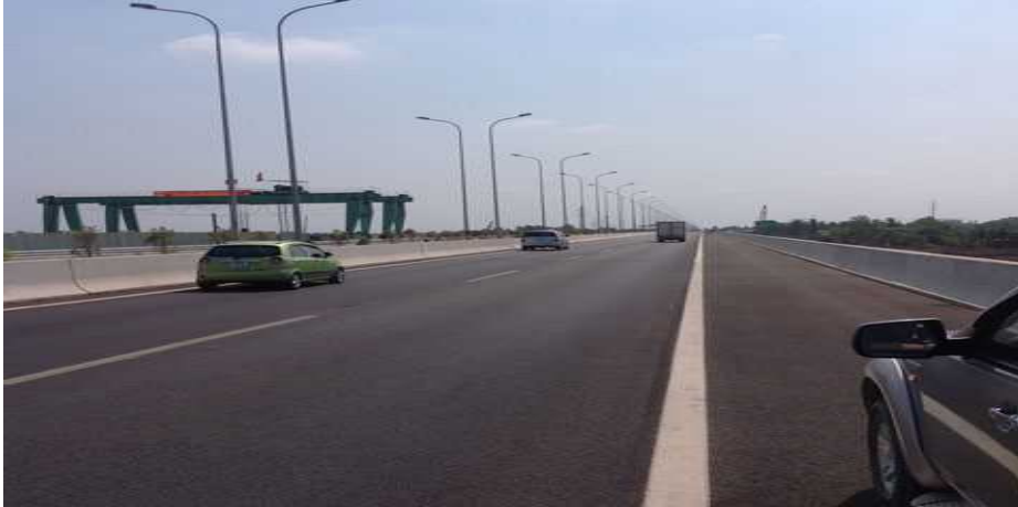
ベトナム：南北高速道路（写真提供：JICA）
