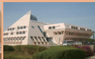
L'université est provisoirement abritée par le Institut National de Mubarak City
