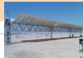
▲ Site de construction prévu (Photo: JICA)
