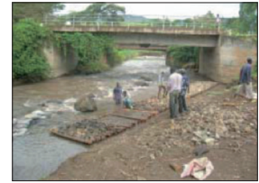
Construction d'ouvrages de protection des berges
