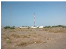
▲ Site de construction prévu (Photo: JICA)
