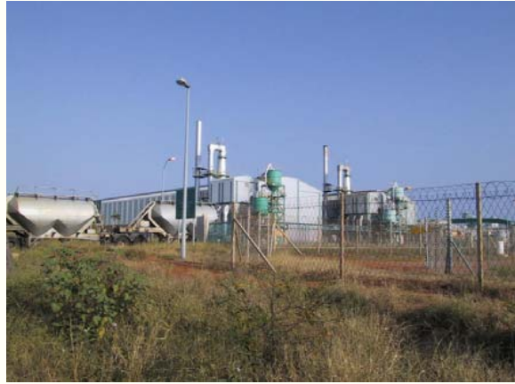
Usine d'affinage d'Aluminium "MOZAL" (Mozambique) Une réussite exemplaire de l'investissement en Afrique. Des entreprises japonaises, la Banque Japonaise pour la Coopération Internationale (JBIC) et Nippon Export and Investment Insurance (NEXI)* y participent également. *Agence Japonaise d'assurance-crédit à l'exportation et d'assurance-investissement
