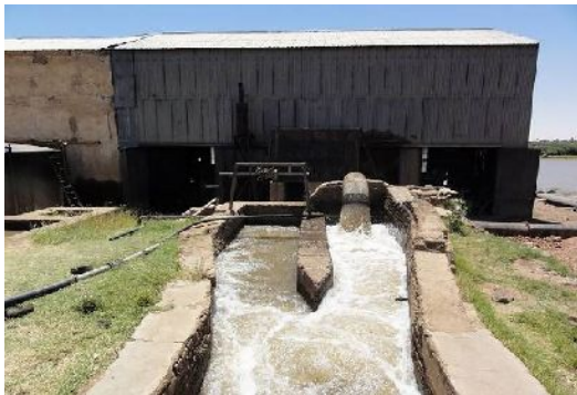
破損した水路
