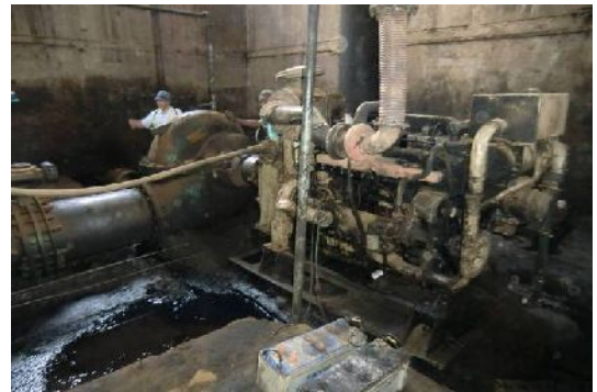
老朽化したポンプ施設
