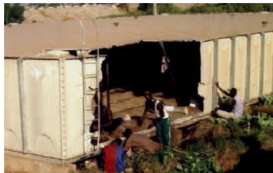
破裂した既存の貯水槽
