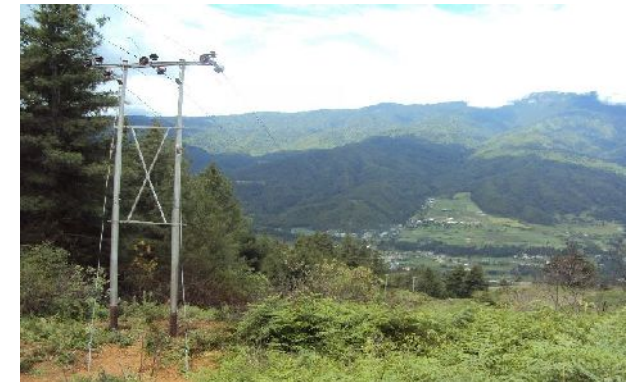
【フェーズ1の支援で完成した電柱と配電線】
