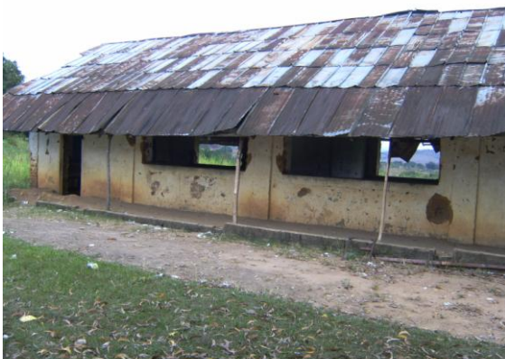
既存小学校校舎
