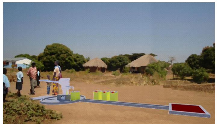
ハンドポンプ付深井戸給水施設
