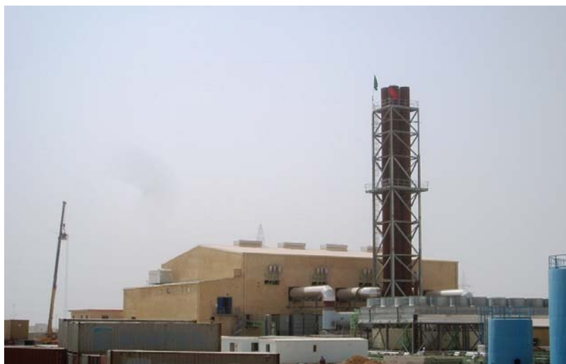
<日本の支援により建設されたサマーワ大型発電所>
