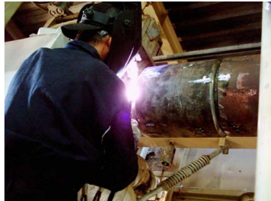
発電所内設備の修理
