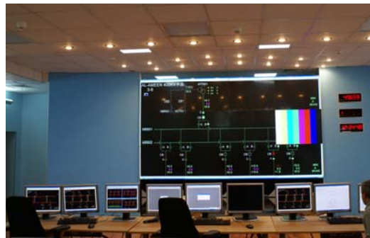
改修を終えたコントロールルーム
