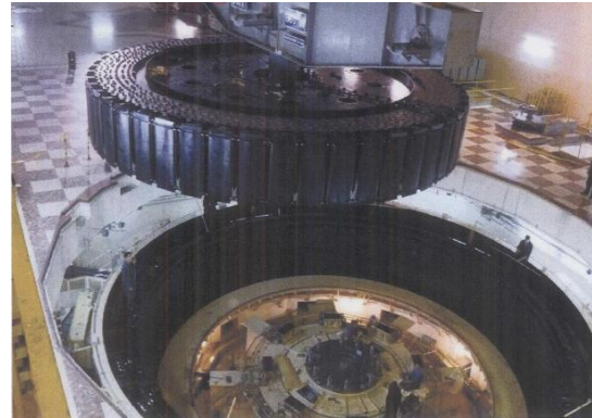
2号機の回転子(ローター)の設置
