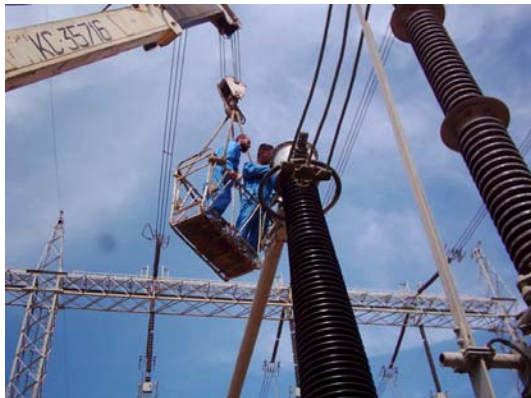
変電設備の改修
