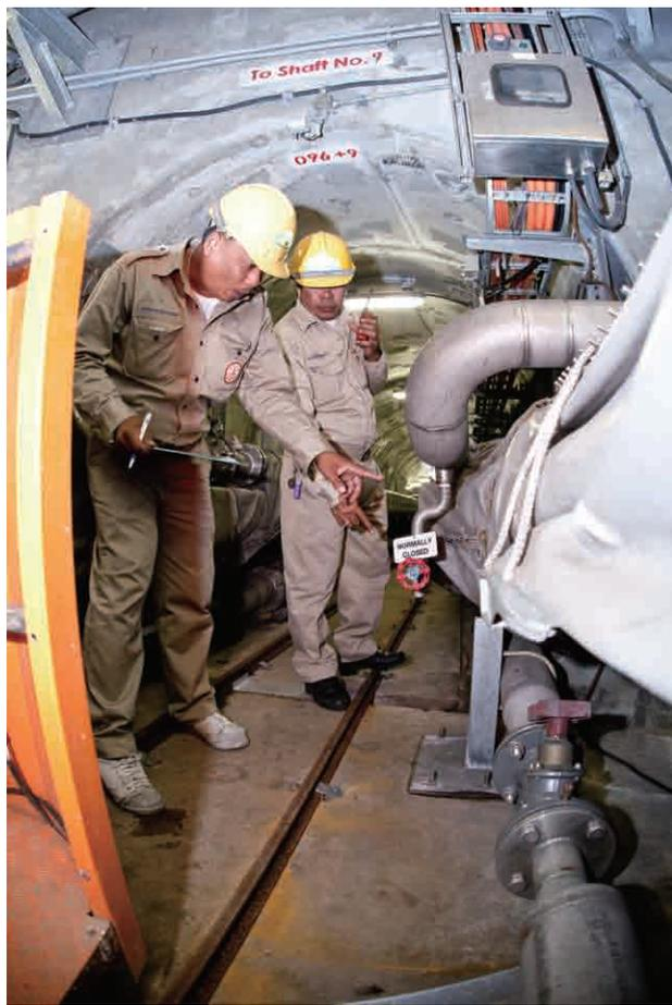
タイ・バンコク中心部のチットロム変電所とバンカピ変電所をつなぐ地中送電ケーブル。既存のケーブルは損傷や老朽化が著しく、維持管理が困難となったため、日本の支援により両変電所間に地中送電用トンネルの建設と、新規送電ケーブル2回線の敷設をしている(写真:久野真一/JICA)
