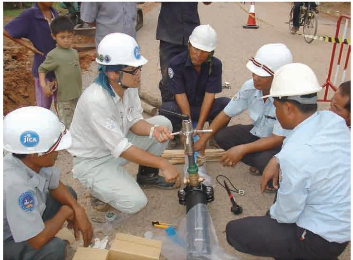
カンボジアで北九州市上下水道局職員の専門家が配水管敷設について技術指導をしている様子（写真：JICA）
