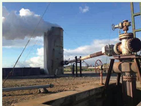
コスタリカの「グアナカステ地熱開発セクターローン-ラス・パイラスII」で噴気試験の様子(写真: JICA)
