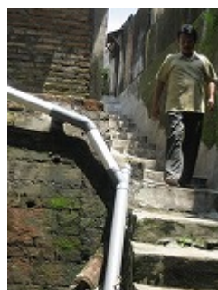
排水管が敷設されたコミュニティ
