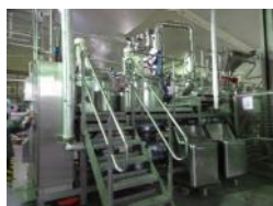
トマト加工設備
